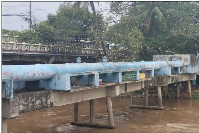
**Gambar 1.1 Jembatan Pipa Pembuangan**
