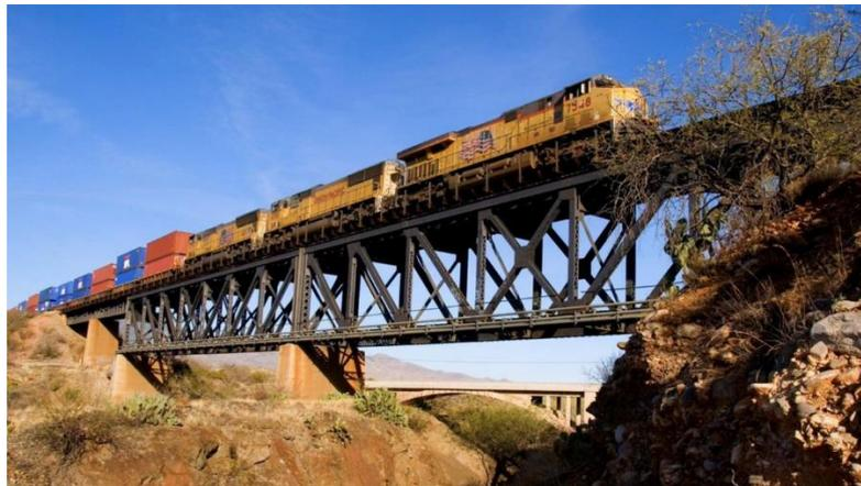
**Gambar 3.1 Struktur Jembatan Rangka**
